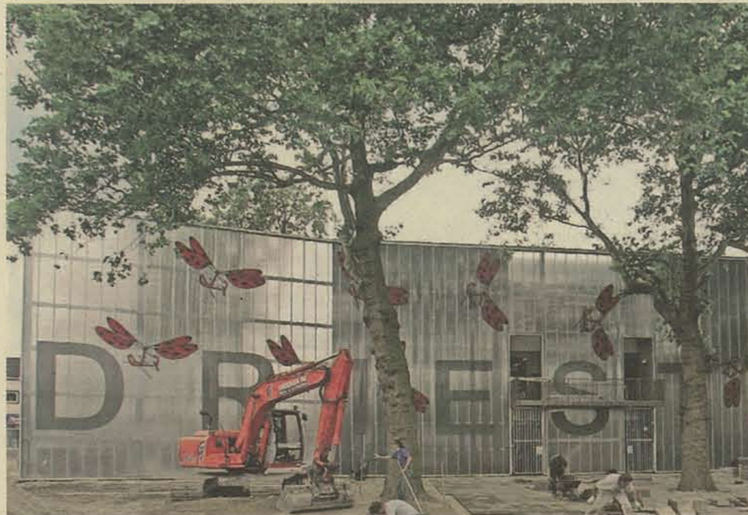
Bij de nieuwbouw van basisschool De Driestam wordt gewerkt aan de bestrating voor het gebouw.
