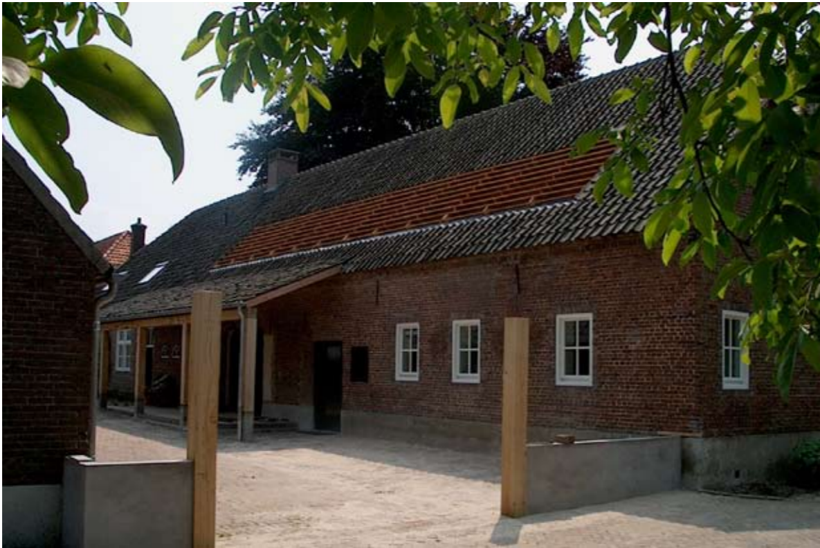
daklicht met lamelen tbv daglichttoetreding zolder
